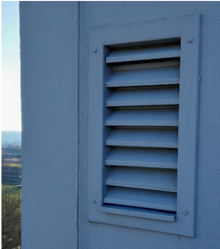
Abbildung 4: Ausgang des Lüftungskanals von außen
