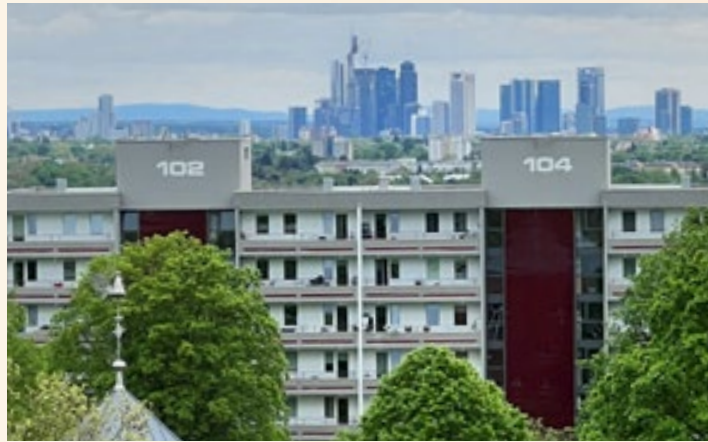
Neue Aufzugsanlage für das BGR-Quartier der GWH
