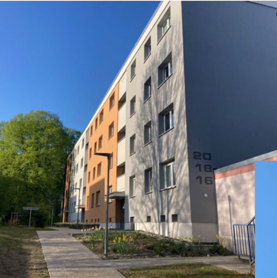
Modernisiertes GWH Quartier im Schelmengraben
